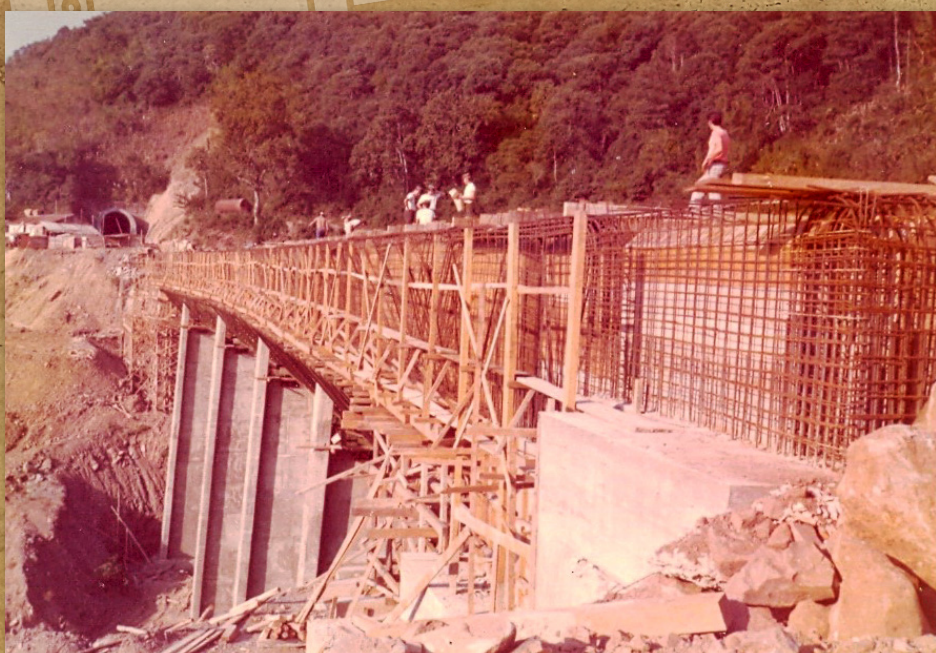
Viaduto 13 | Execução da superestrutura
