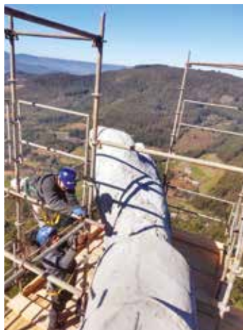
10 | Aplicando uma das inúmeras camadas de massa que foram feitas na mão
