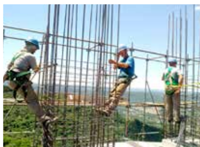
5 | Início das ferragens dos pilares de sustentação que vão desde a base até o topo
