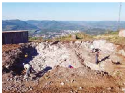
1 | Perfuração, detonação e limpeza da rocha para dar início à obra
