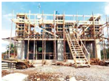
3 | Montagem dos painéis da terceira laje do monumento
